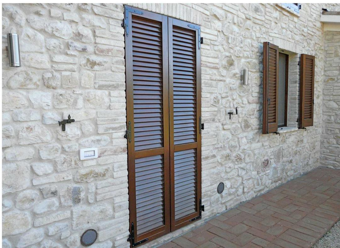
Le **Persiane in Legno** con lamelle fisse inclinate vengono realizzate in diverse varianti quali sportellini apribili (gelosie), ferramenta con squadre o bandelle a vista o a scomparsa, ferrate su telaio o su cardine a murare.
